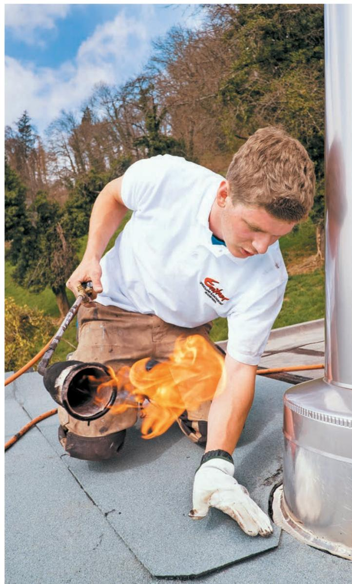
Mit einem Gasflämmer klebt Lehrling Alexander eine Bitumenbahn auf das Flachdach.
